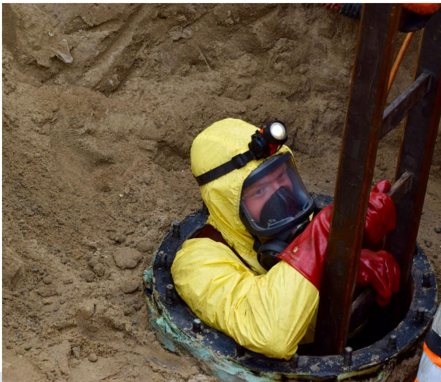
Foto 1: Het schoonmaken van de tank.
