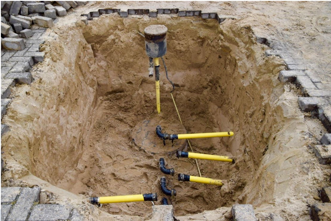
Foto 10: Controle van tank en leidingwerk.
